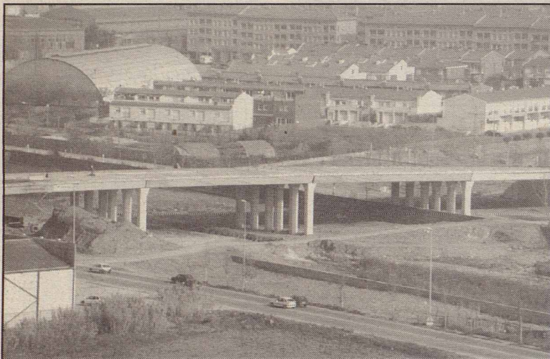
Obres de la Ronda Sud sobre el riu Congost
