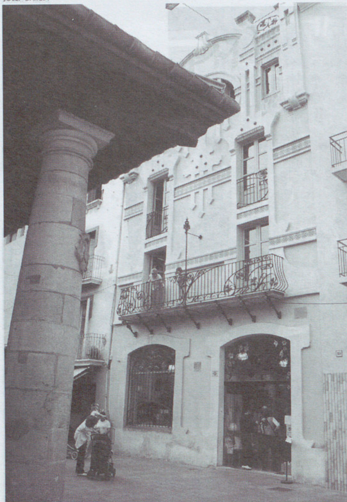
Casa Clapés de Manuel J. Raspall a la Porxada.
