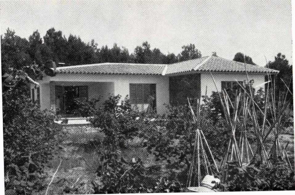
Chalet construïdo para D. Francisco Guardiola Moya en la urbanización «Torras» por el contratista D. Mateo Dantí Sala. (Foto Patricio Valls)
