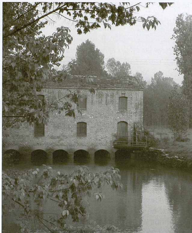
Comporta del Canal Industrial de Manlleu Fotografia: Carme Sánchez
