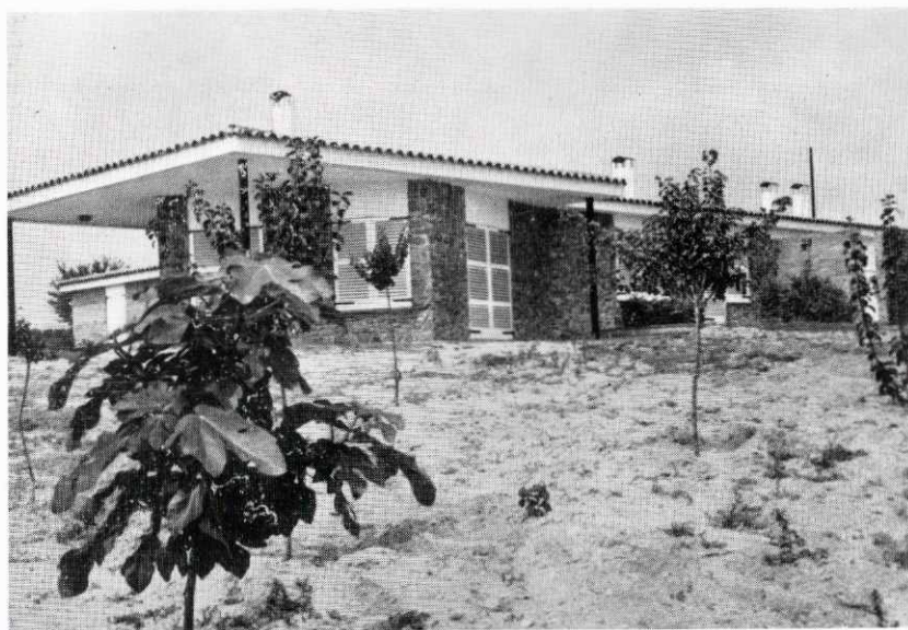
Chalet construïdo para D. Antonio Romagosa Geis.
