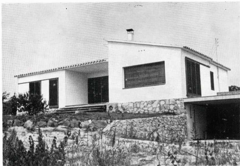
Chalet construïdo por COVASA para el Sr. Luis Brustenga
