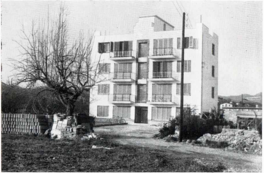
Vista del primer bloque de viviendas construido por COVASA en el Rieral.
