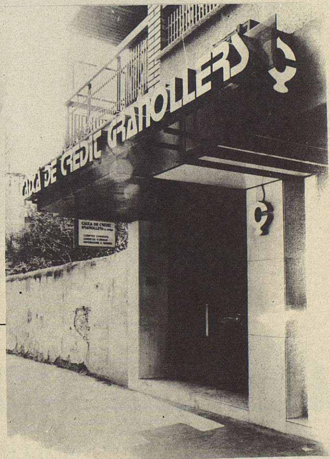
Fachada de la oficina central, en Avda. San Esteban.
