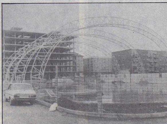
L'estructura del pavelló
