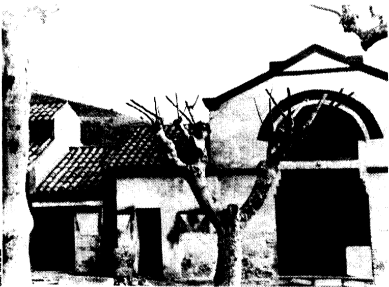
Edifici de l'escorxador municipal, on s'ubicarà la nova escola-taller. La primera tasca serà la rehabilitació de l'edifici.
