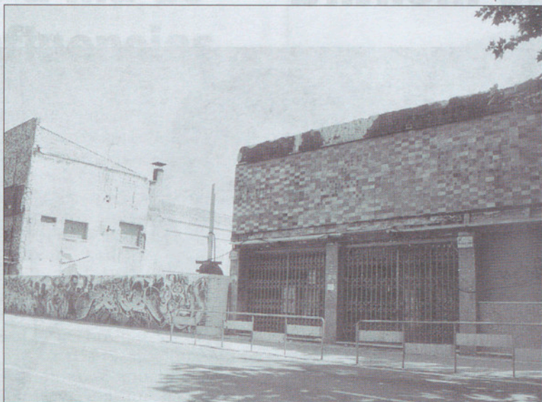
El edificio ya ha sido derribado.
