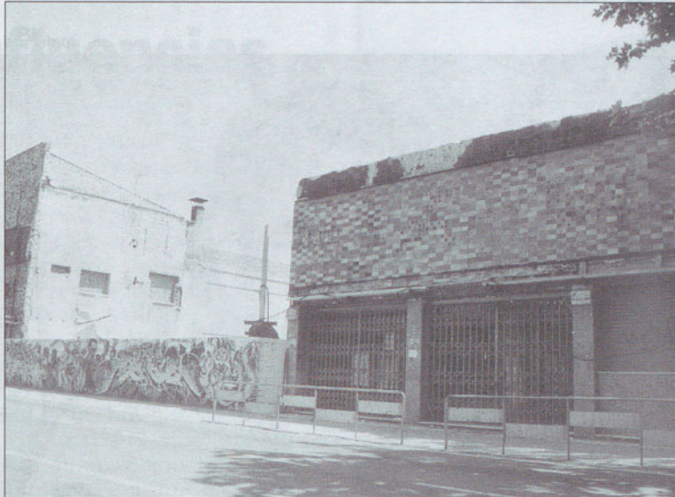
El edificio ya ha sido derribado.
