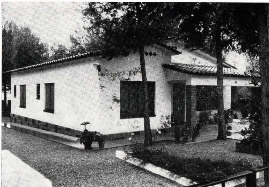
Vivienda construida por Mateo Dantí Sala, para D. Santiago Olivé Martínez en urbanización «Can Torras»
