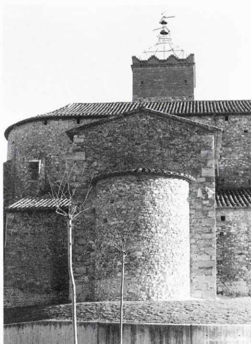
Vista d'una part lateral de l'església, amb la capella del Santíssim en primer terme.
