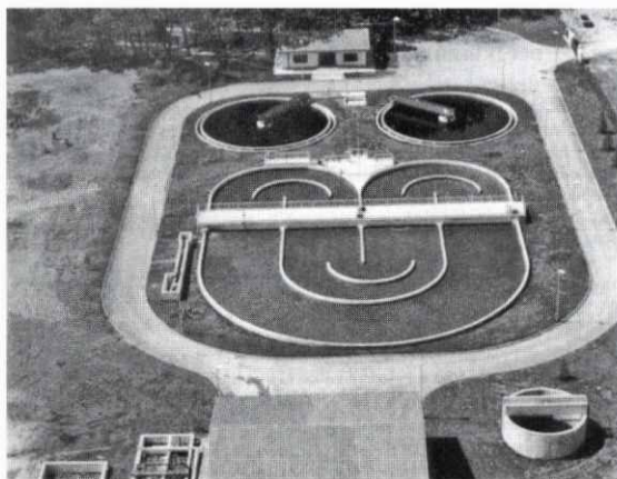
Vista general de la Depuradora de Santa Eulàlia.
