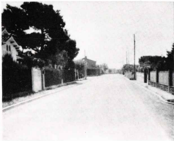
Obres de pavimentació del camí de la Serra
