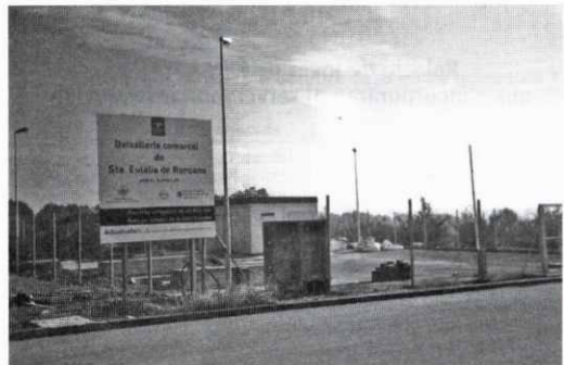
La deixalleria de Santa Eulàlia, en construcció
