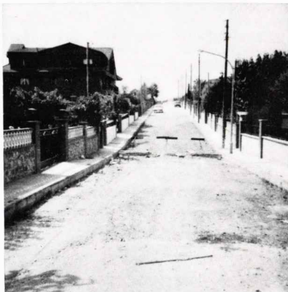
Reforç de la pavimentació de la zona urbana de Can Juli
