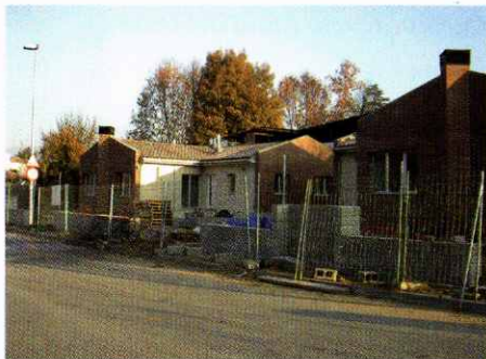
Habitatges Socials de Can Font.
