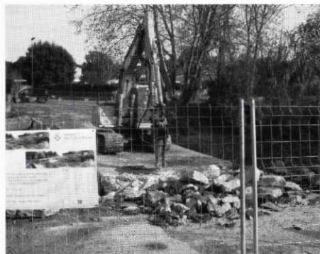
Obres al gual de Sant Isidre.
