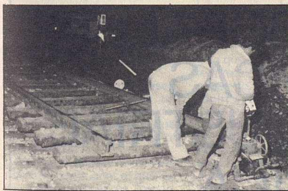
Les obres del pas per a vianants.
