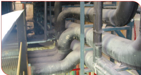
Connexió amb l'edifici industrial
