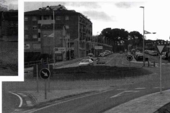
Les obres de la carretera, pràcticament acabades.
