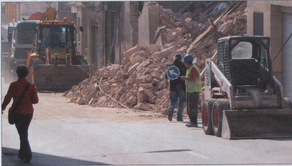
La Brigada de Obras trabajó para volver la normalidad a la carretera.
