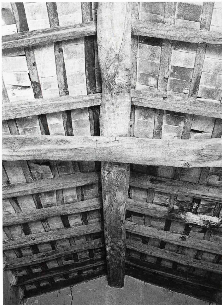
El sostre de la sala.
