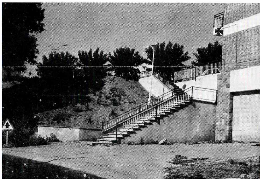
Nueva escalera de acceso a la Plaza del Ayuntamiento desde la carretera
