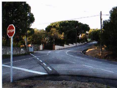
Nou asfaltat al camí del Serrat.
