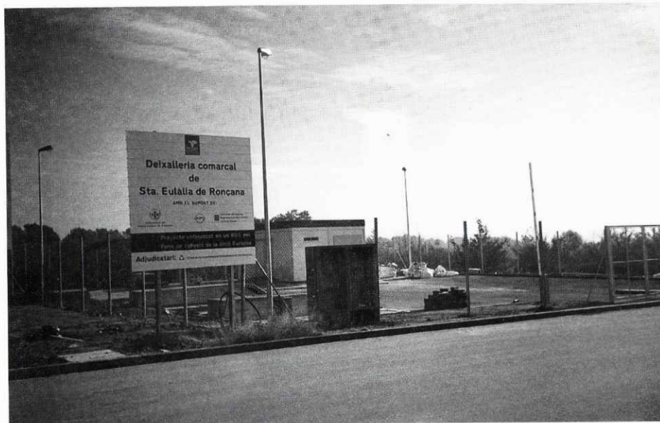
La deixalleria de Santa Eulàlia, en construcció.
