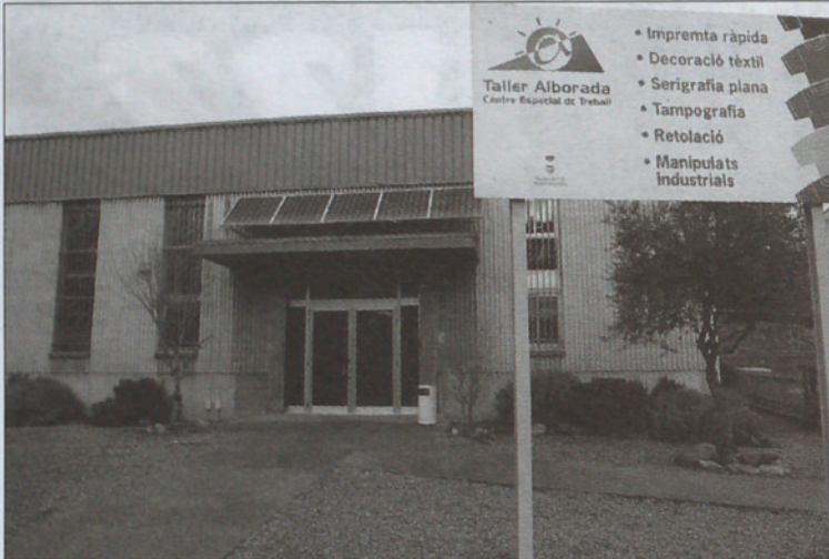
Vista exterior del edificio que alberga el Taller Alborada, en el barrio de Can Pantiquet.
