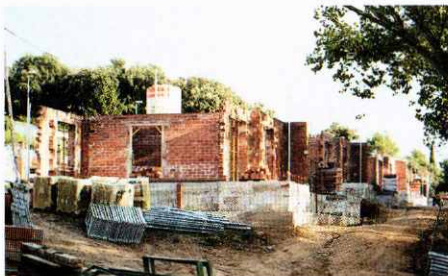
Els habitatges Socials en construcció.
