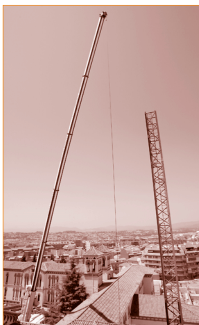
Les grues de 40 metres que aixecaran la nova construcció
