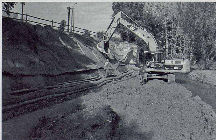
Consolidació dels marges de l'entron de la Font de Sant Cristòfol amb tècniques de bioenginyeria.
