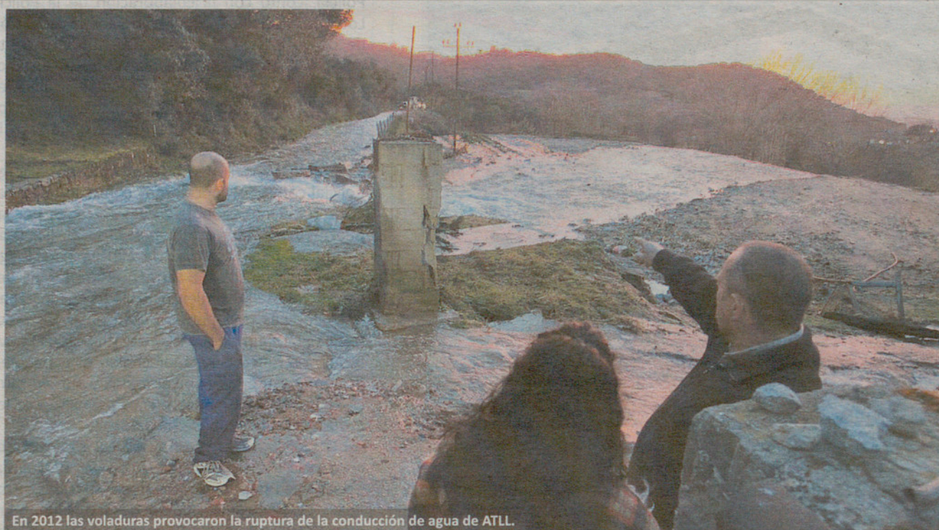
En 2012 las voladuras provocaron la ruptura de la conducción de agua de ATLL.
