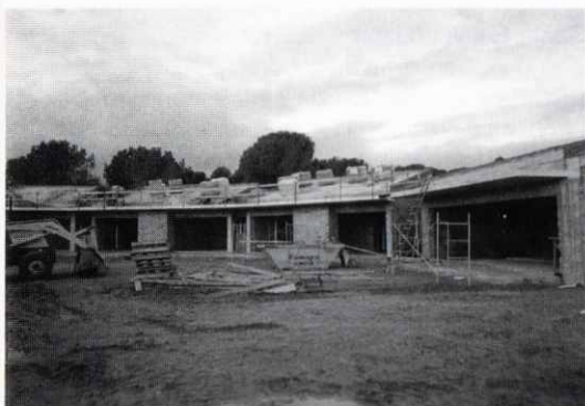
Les obres de l'Escola bressol.
