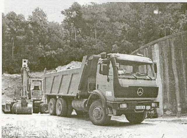
Construcció d'un nou dipòsit d'1.5 milions de litres a Can Planes
