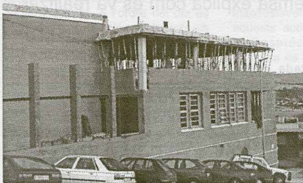
Vista de l'estat en què es troben les obres
