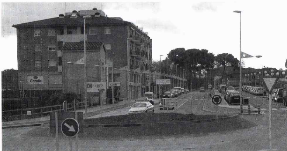
Les obres a la carretera, pràcticament acabades
