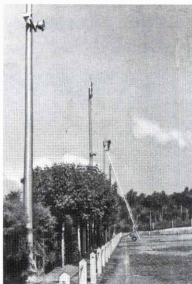
Instal·lació de la il·luminació al Camp Municipal d'Esports.
