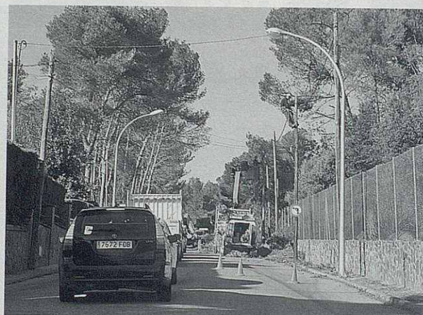
Reparació al camí de Can Vendrell.
