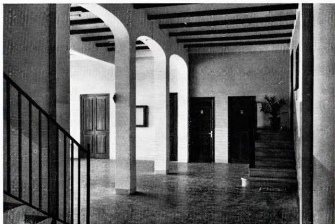
Vestíbulo de la planta baja con los aseos públicos al fondo
