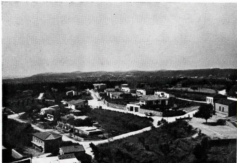
Panorámica del Barrio La Sagrera.
