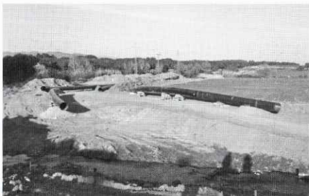
Els tubs del gasoducte ja travessen Santa Eulàlia.
