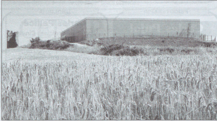
Los depósitos, ubicados junto a la torre Pinós, aseguran el suministro de agua potable a la Comarca.
