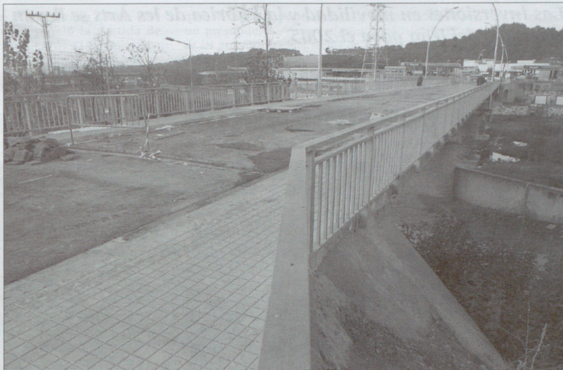
Los vehículos pueden volver a entrar a la ciudad por el remodelado puente.
