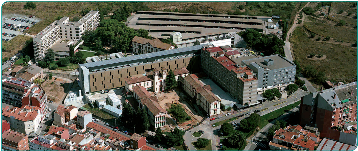
Vista aèria de tots els edificis que formen part de la Fundació Hospital-Asil de Granollers, amb el flamant nou edifici de consultes externes a la part esquerra de la fotografia
