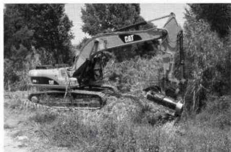
Comença el pla de millora de l'espai fluvial del Tenes.
