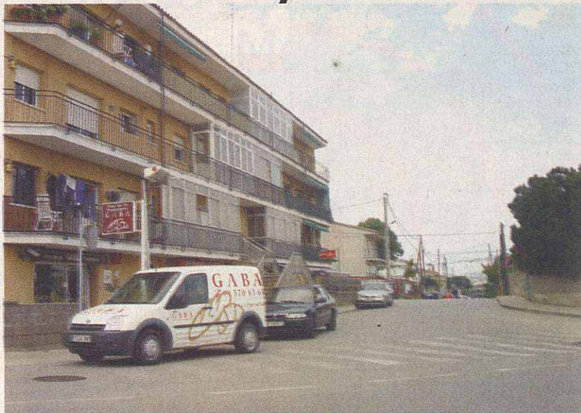
Les obres a l'Avinguda Catalunya duraran uns sis mesos
