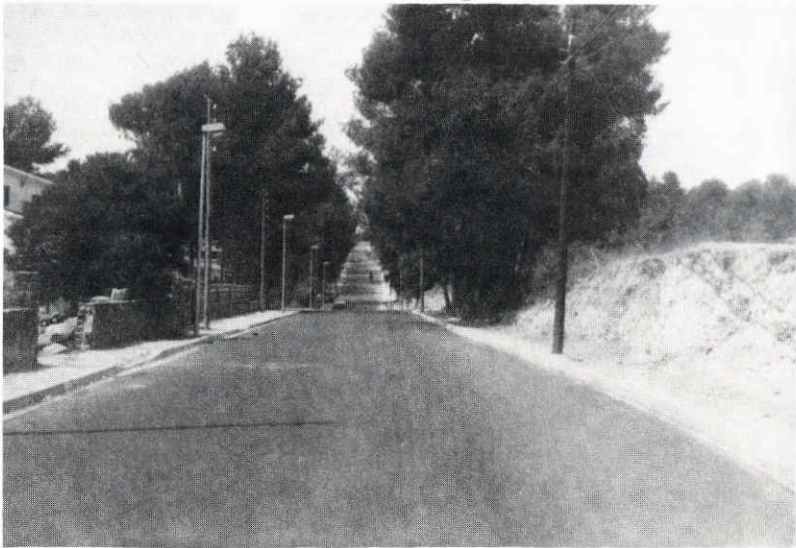
La carretera de Caldes, ja asfaltada, prop de la Font d'Abril.
