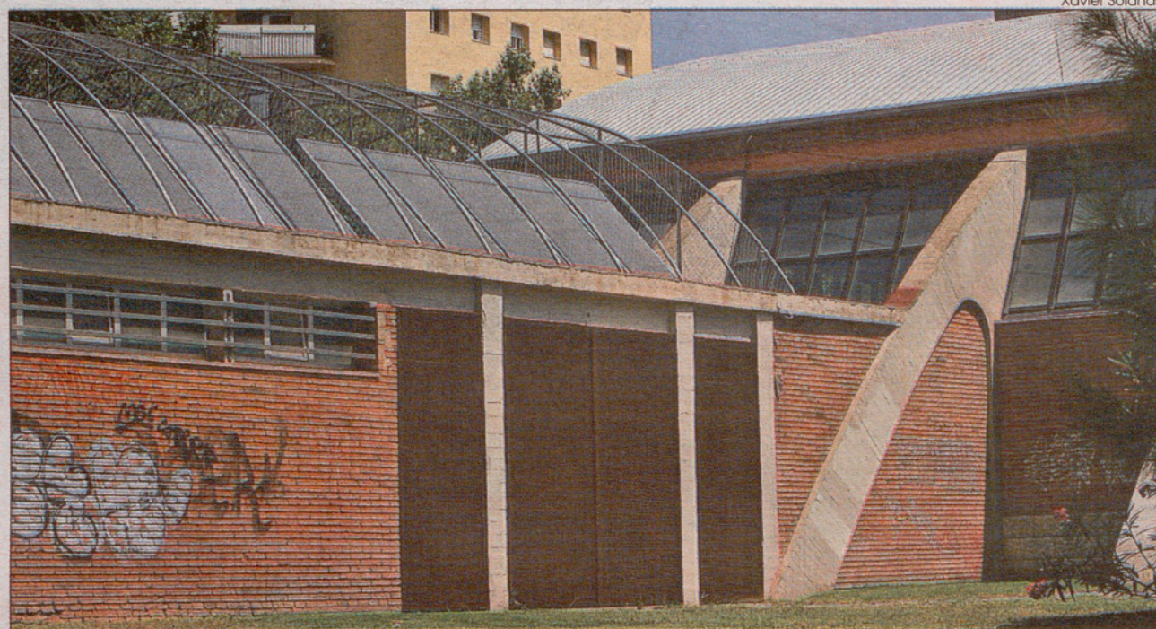
Los paneles térmicos se colocan en todas las obras municipales de nueva construcción.
