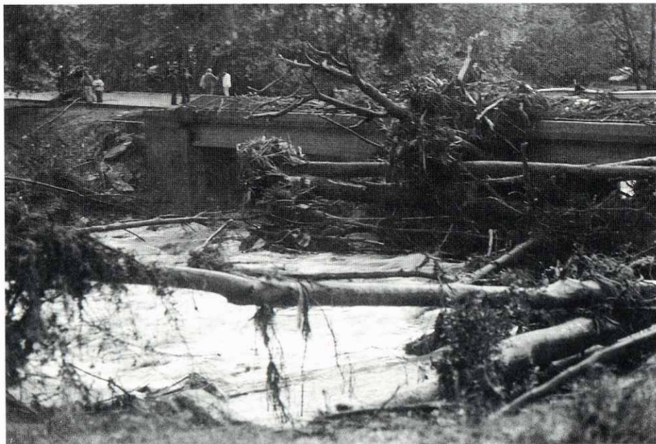
Els efectes de la riuada al pont de St. Cristòfol, al Rieral.
