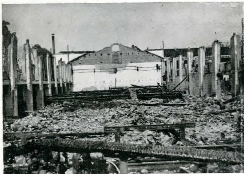
Una de las cuadras de la fábrica de Roca Umbert, completamente incendiada
